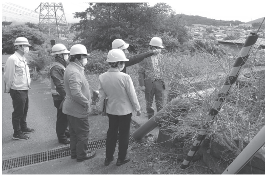
▲美園町擁壁崩壊現場の現地視察の様子
