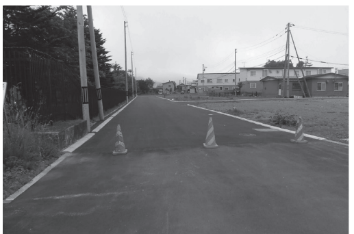
▲緑町市道路線の現地写真
