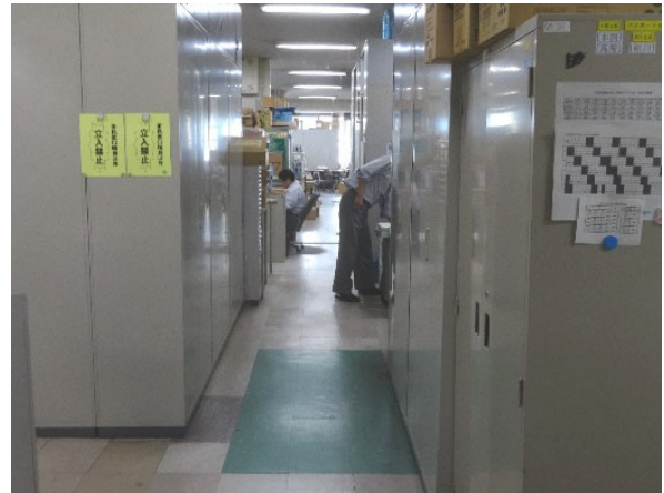
車いすがすれ違うには困難な狭隘な廊下
