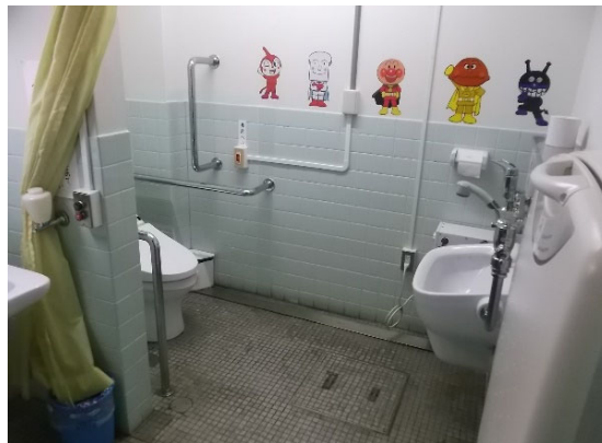
多目的トイレ（1階のみ設置）
