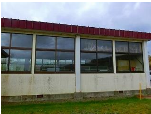
5-3 外壁② (実習棟)
