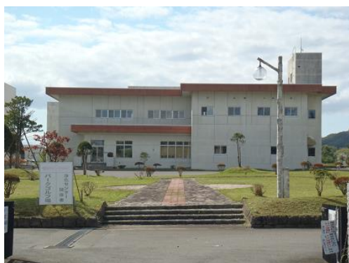
若山浄化センター
