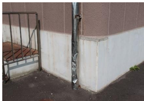
14-4 屋根・屋上（雨水ドレン）
