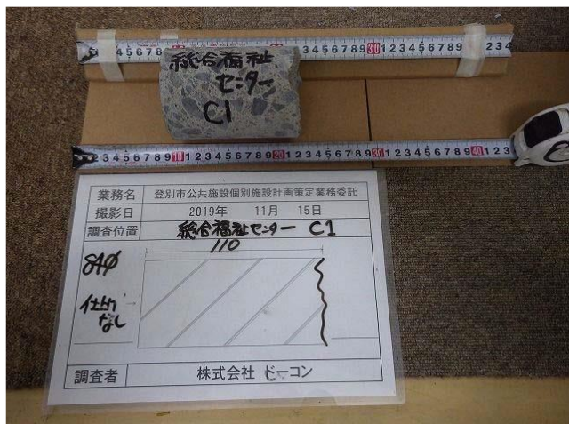
コンクリートコア採取の状況
