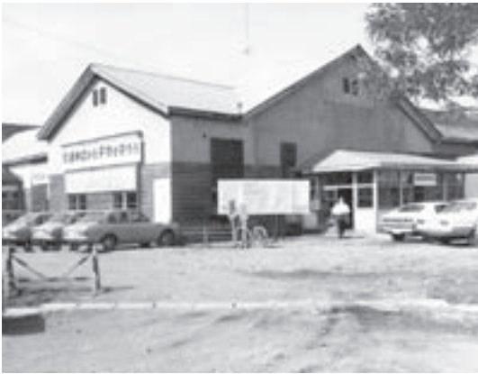
▲工事期間中に使用された仮庁舎
