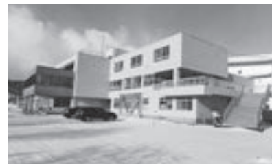
▲平成30年度から耐震化・改修工事を始めた幌別西小学校（上）と富岸小学校（下）
