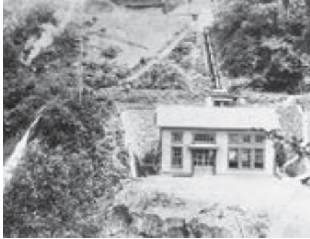
▲昭和初期に新たに建設された水力発電所と煙を上げながら走る蒸気機関車(塚田登さん撮影)
