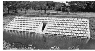
▲平成30年3月に完成した雨水を川に排水するための吐口(常盤町地区)
