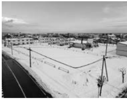
▲千代の台団地の建て替えに当たり、解体工事が完了した敷地
