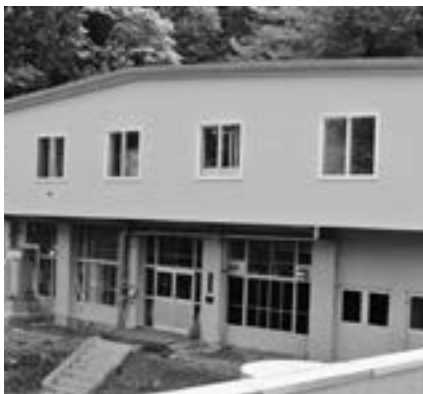
▲安全安心な水道水を供給するため、建て替えを行う登別温泉浄水場
