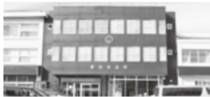
▲平成29年度に外壁など、最低限の改修を行った市役所本庁舎
