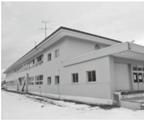
▲平成29年度に耐震改修を行った登別中学校
