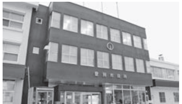
▲安全に利用できるよう最低限の修繕を行った本庁舎
