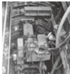
▶平成28年度に驚別町で行った配水管改良工事
