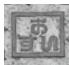
▲汚水の表示がされているマンホールのふた
