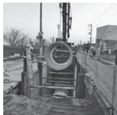
▲平成28年度に行われた雨水管渠の整備工事
