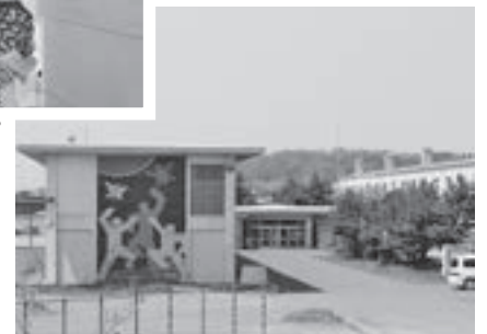
▲解体工事が進められている旧校舎
