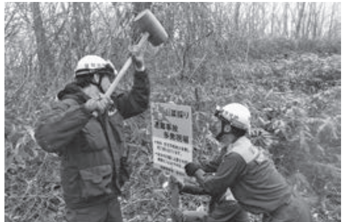
▲道路わきに看板を設置する職員
