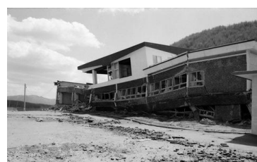
半倒壊した病院
