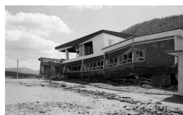
半倒壊した病院
