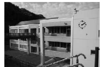
室蘭市 星蘭中学校太陽光パネル
