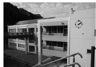
室蘭市 星蘭中学校太陽光パネル
