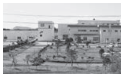
▲市内の下水処理を行っている『若山浄化センター』
