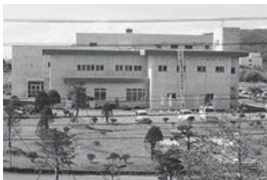
▲汚水などの処理を行う若山浄化センター
