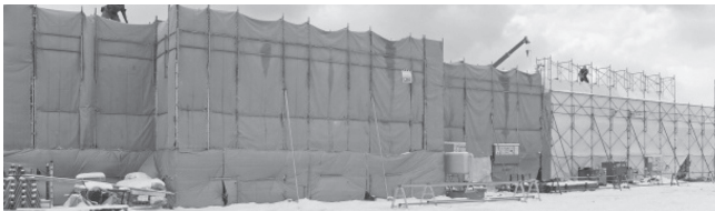
▲建て替え工事中の鷺別小学校
