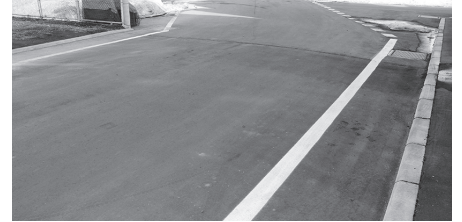
▲市民生活を支える市道（写真は中央町）
