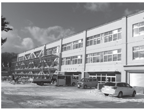
▲耐震化を進めている青葉小学校の校舎
