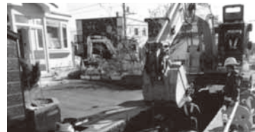
▲道路排水対策工事
