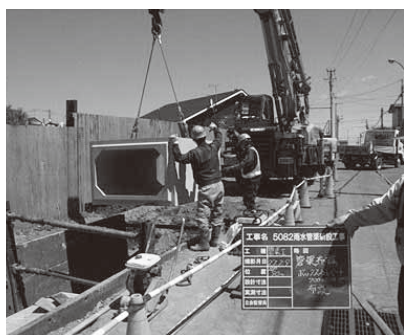
▲浸水被害を防ぐために行う雨水管の整備
