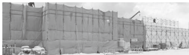
▲建て替え工事中の鷺別小学校
