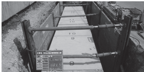
▲下水道事業では、雨水の浸水対策として雨水管渠の整備も行う
