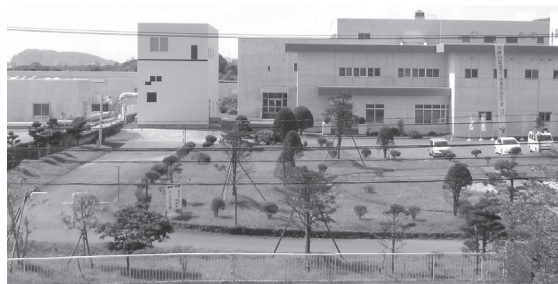
▲市の下水処理を行っている『若山浄化センター』
