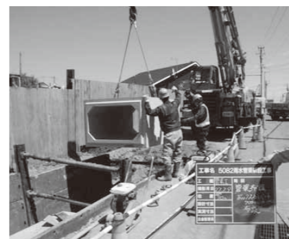
▲平成26年度は、中央町地区と若山町地区で雨水管を新設した
