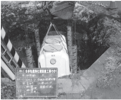
▲下水道が整備されていない地域の方のために浄化槽の設置事業
