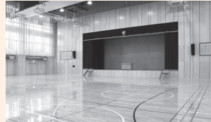
△鷺別小学校体育館
