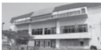
▲延命化を図るため工事を予定している総合体育館
