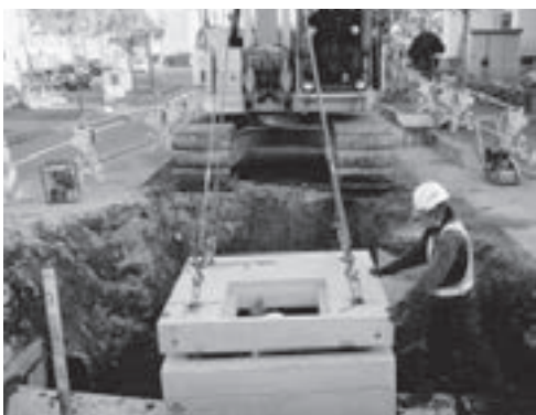
▲排水路設置工事
