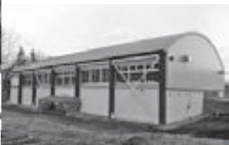
▲耐震化工事を終えた登別小学校の体育館
