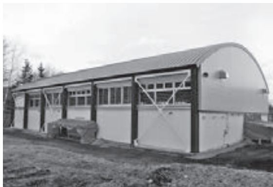
▲耐震化工事を終えた体育館（登別小学校）
