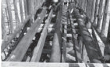
▲改修中の木道
