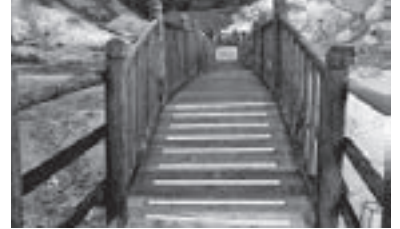
▲改修後の木道
