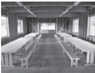
▲休憩施設（内部）
