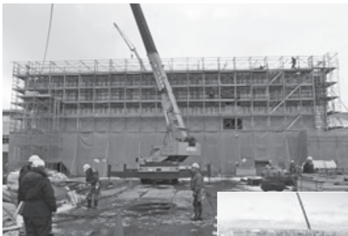
▶▶体育館の建て替え工事
