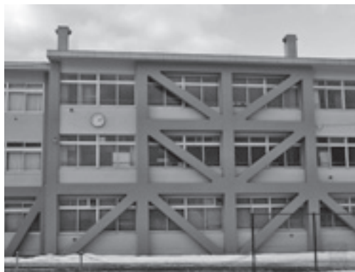
▲耐震化工事を終えた校舎（鷺別中学校）
