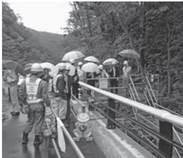
▲道道改良工事現地視察の様子
