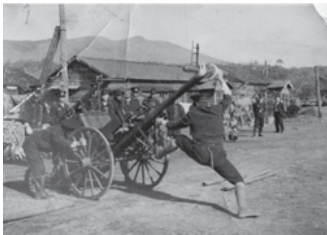
▲消防訓練で使用するポンプを移動させている様子（昭和25年）
