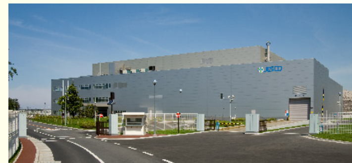
平成20年5月に操業を開始したPCB廃棄物処理施設(室蘭市)
