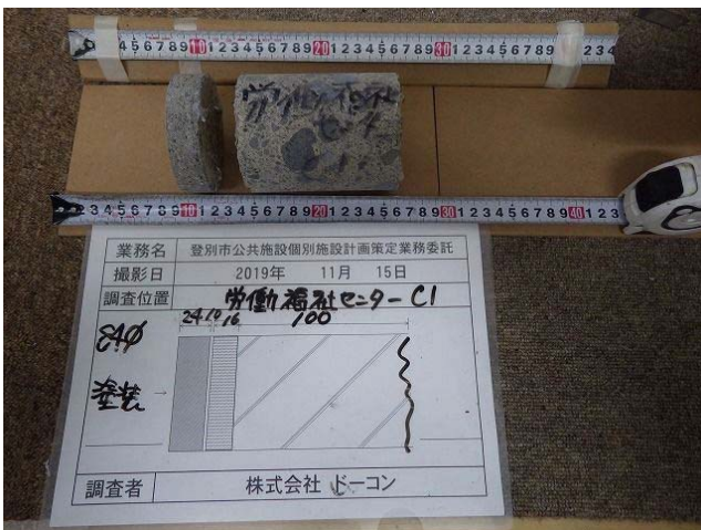
コンクリートコア採取の状況
