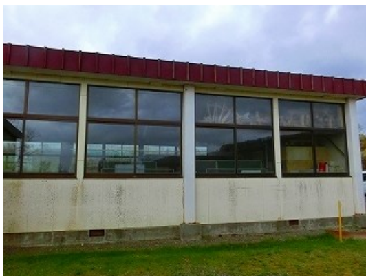
5-3 外壁② (実習棟)
