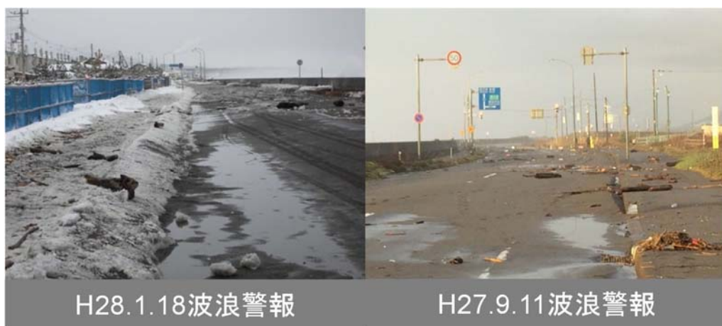
図 2-20：登別海岸の越波による通行止めの様子
