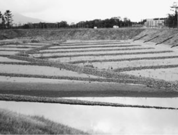
▲廃棄物管理型最終処分場
