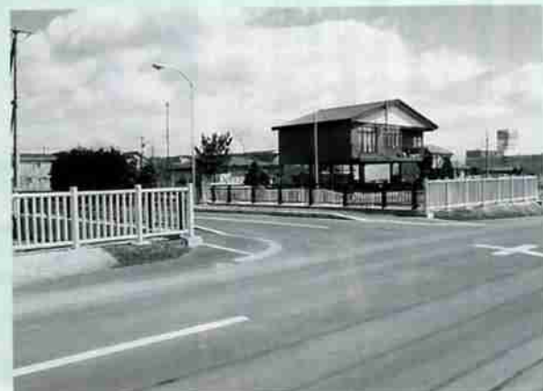
▲富岸8号橋「にこにこ橋」
