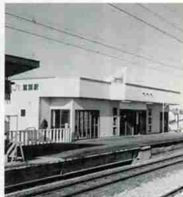
▲鷺別駅新駅舎
