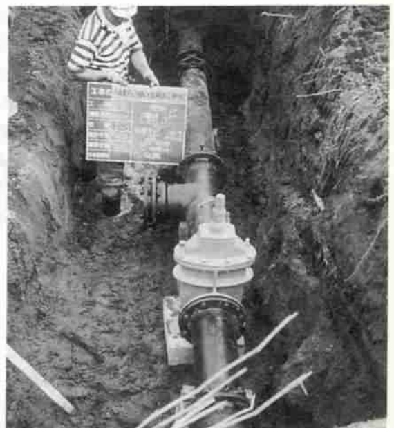
▲進む配水管の改良工事
