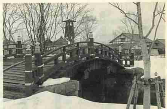
美しい曲線を描く木橋
