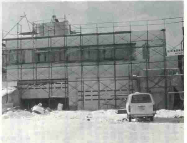
建設が進められている消防署 鷺別支署
