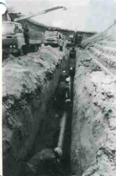
上水道を統合する配水管の敷設工事
