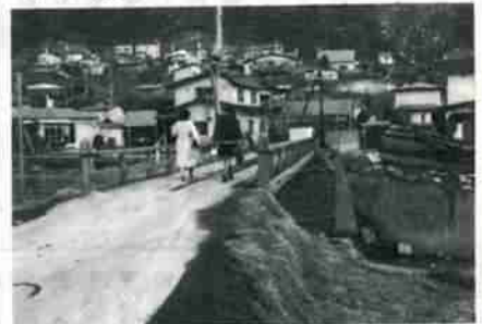
永久橋に生まれ変わる、美園町の東橋
