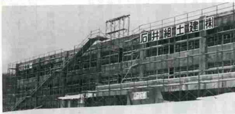
青葉小学校は4月開校予定で新設中。
