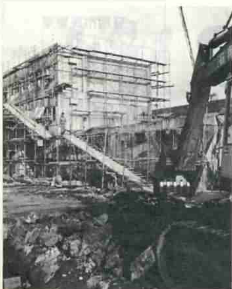
昨年おこなわれた梶別中学校校舎増改築工事
