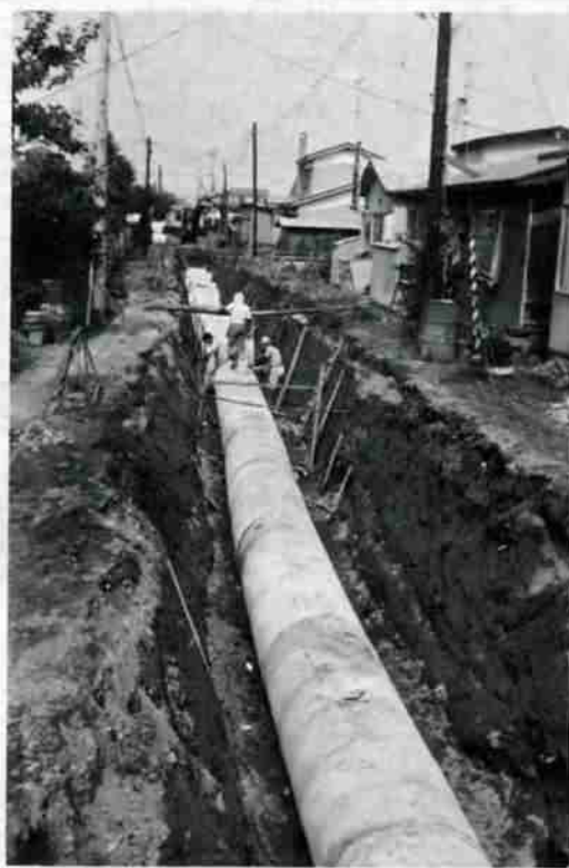
市街地の幹線排水路をはじめ、地域の排水整備によって快適な街づくりが積極的にすすんでいます。
