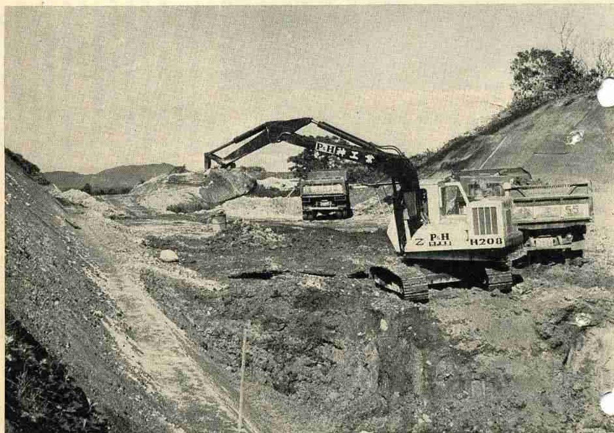
はまなす団地裏を急ピッチでおこなう掘削作業
