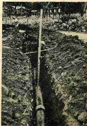
配水管布設工事および改良工事
