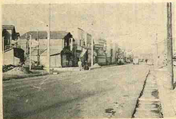
中央通り舗装工事
