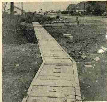
登別地区第3工区 排水路工事
