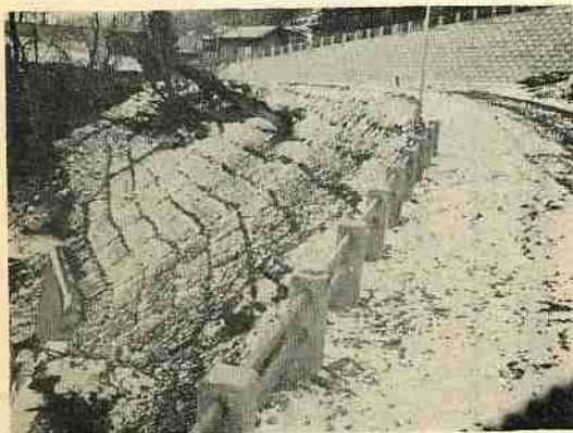
登別温泉通学道路 1号線災害復旧工事
