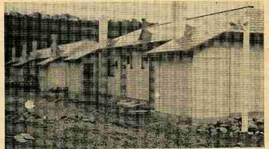
公営住宅完成
