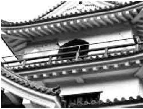
▲震災で外壁がはがれた白石城
