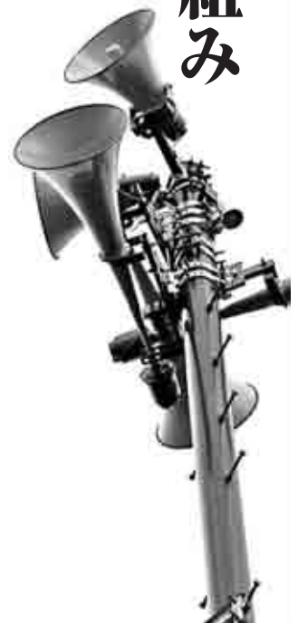
▲サイレン遠隔吹鳴装置
